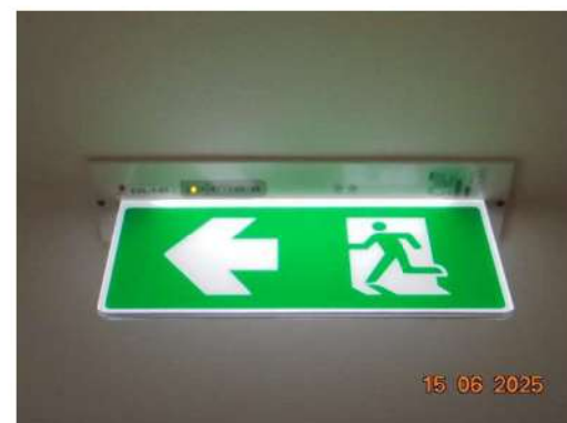
ตรวจเช็คระบบไฟฉุกเฉิน ภาพที่ 1.3.8-1(ต่อ) การบริหารจัดการด้านอัคคีภัย ความปลอดภัยและสาธารณสุข
