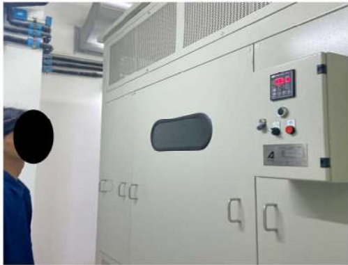
เจ้าหน้าที่ทำการตรวจสอบหม้อแปลงไฟฟ้า
