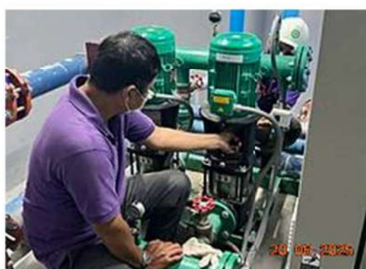
เจ้าหน้าที่ทำการตรวจสอบระบบ Booster pump
